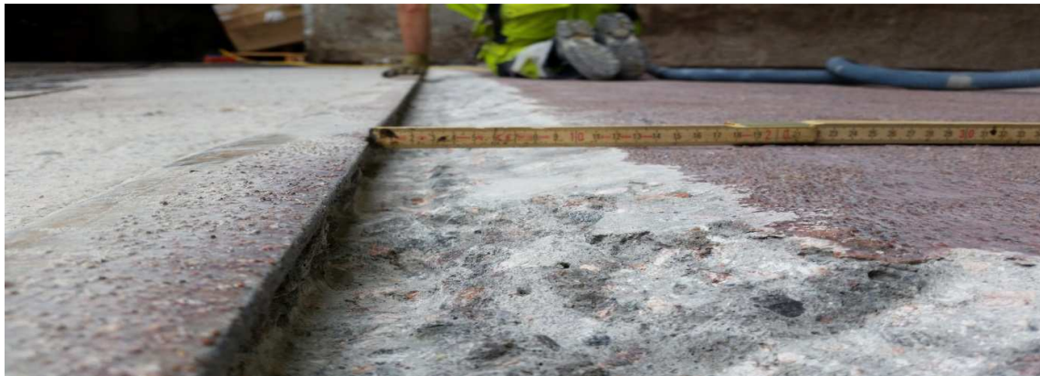
Figur 15: Bilning längs kantstålet för att få en bra övergång med gjutasfalten.
