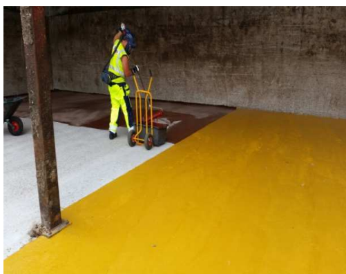
Figur 9: Första lager MMA med sandning på ytan.
