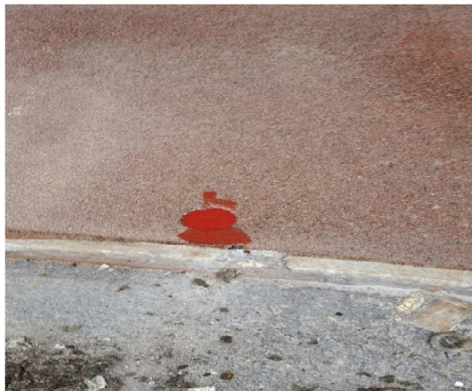
Figur 11: Hålen fylls i med MMA
