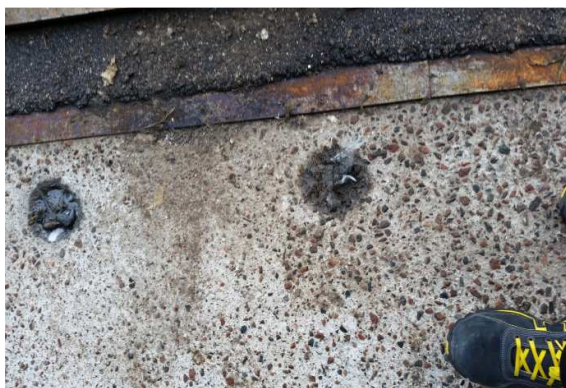
Figur 4: Öglorna nära intill stålkanterna, fulla med matavfall efter högtryckstvätt.
