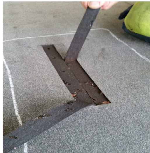
Figur 17: Utförande av rivprov som visade bra vidhäftning.
