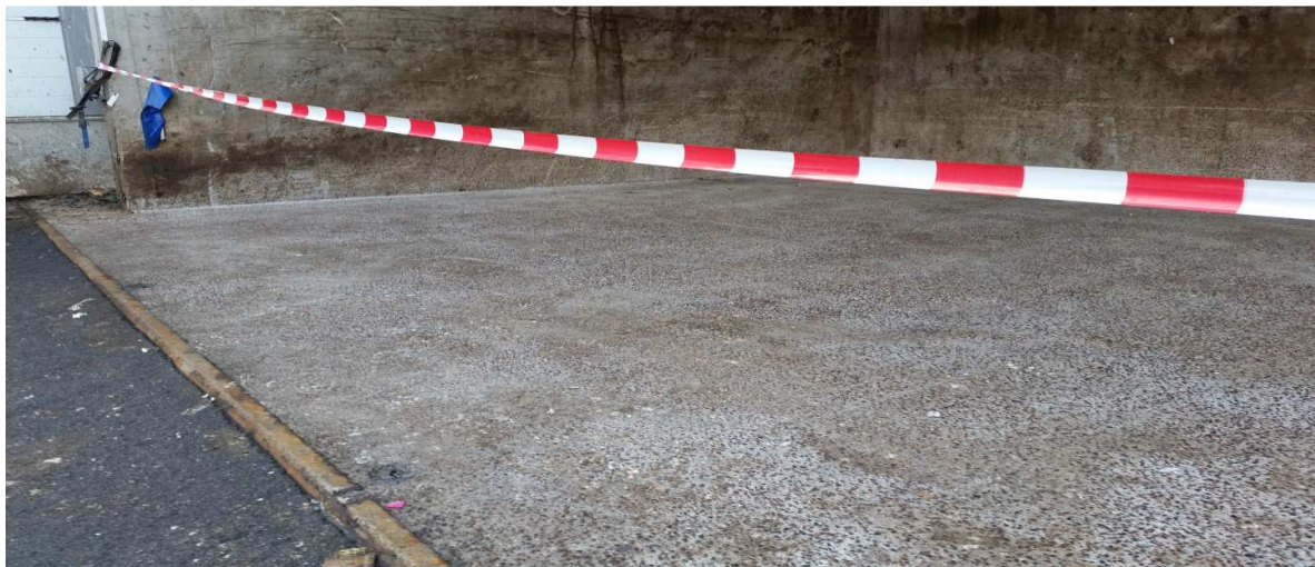
Figur 3: Betonggolvet efter högtryckstvätt och en dags torktid.
