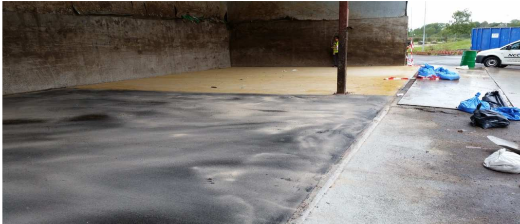
Figur 18: Färdighärdad syrafast gjutasfalt sandad med baskarpsand.
