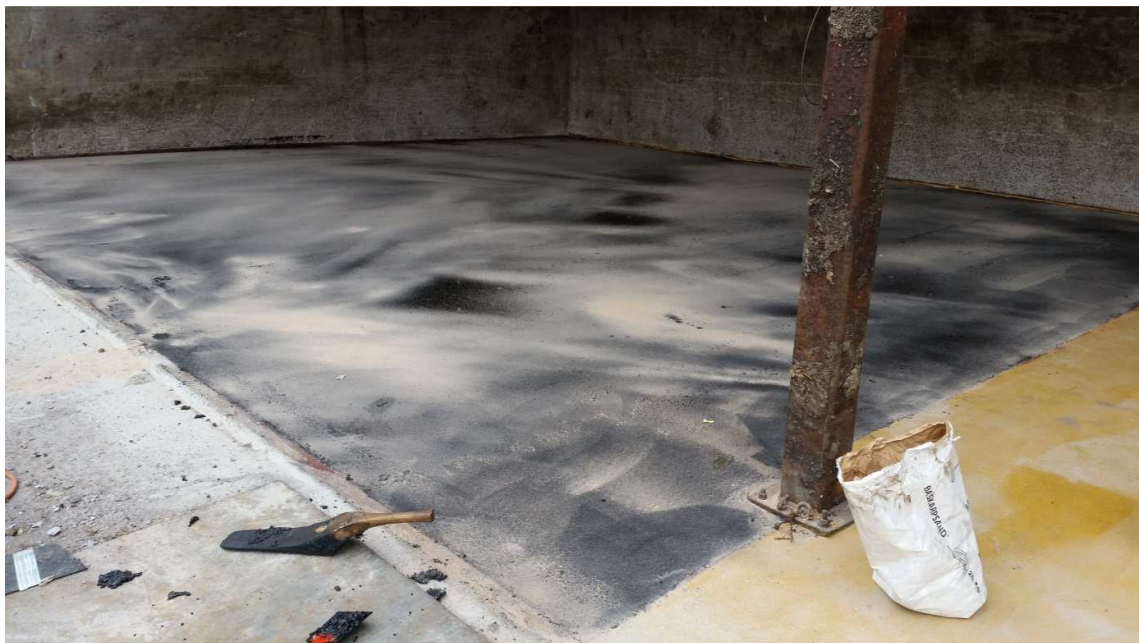
Figur 1. Färdiglagd skyddsbeläggning av gjutasfalt på betonggolv.
